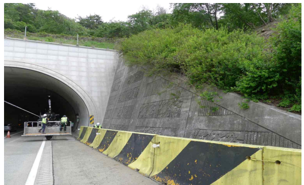
h. 옹벽(시점) 전경
