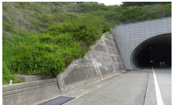
h. 옹벽(시점) 전경
