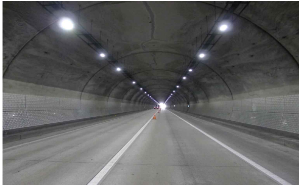
a. 터널 내부 전경
