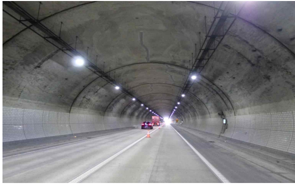
a. 터널 내부 전경
